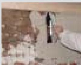
Intonacare la superficie, il nastro resta ricoperto di intonaco e offre una finitura con raccordi sicuri.
